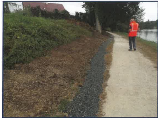
Drain posé côté gauche recouvert de gravillons gris
