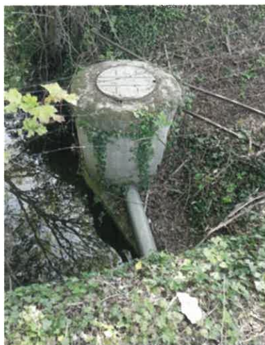
Raccordement côté droit côté station arrivée et retour eaux traitées à la rivière non dénommée affluent de la Canche.
