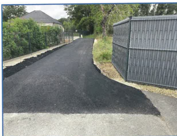
Réalisation d'un enrobé suite à la construction d'un pavillon rue des usages
