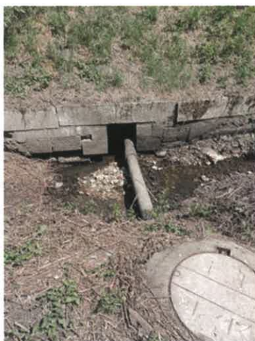
Raccordement des réseaux d'eaux usées passant sous le canal côté gauche du chemin de halage.
