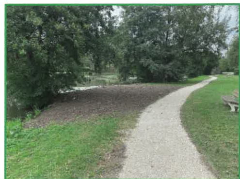
Rechargement en terre d'un point bas de l'étang
