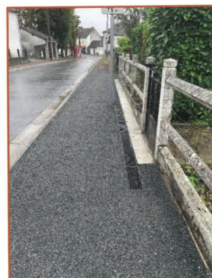
Pose d'un caniveau rue du Lieu suite aux précipitations intenses
