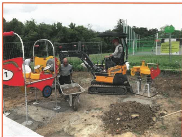
Le terrassement et le scellement des jeux
