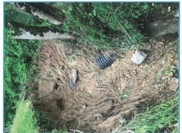
Érosion due à la montée du ruissellement d'eau impasse des Crots Jaunes devant le transformateur EDF côté champ centre équestre.
