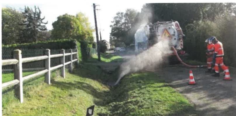
Hydrocurage de l'aqueduc sous la chaussée – rue de la Chaume
