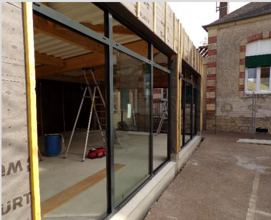
Gros œuvre de la charpente et pose des ossatures métalliques
