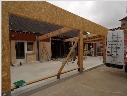
Gros œuvre de la charpente et pose des ossatures métalliques
