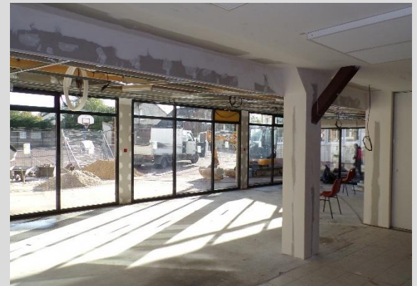
L'intérieur en travaux
