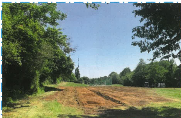
Nivellement du terrain de foot
