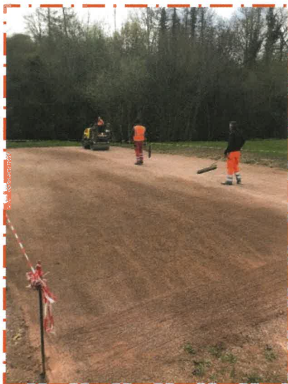
Nivellement et compactage
