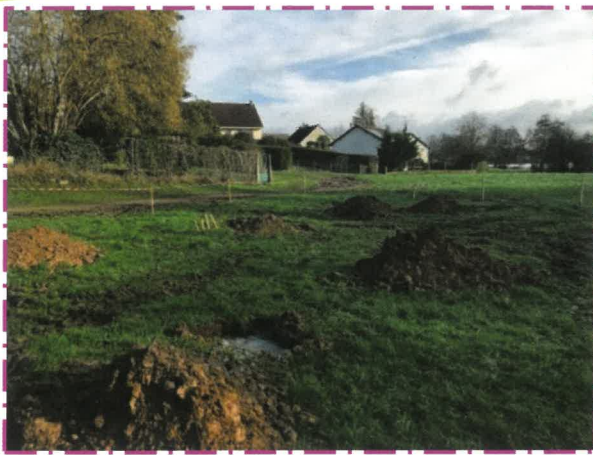
Trous de scellement pour les équipements de fitness
