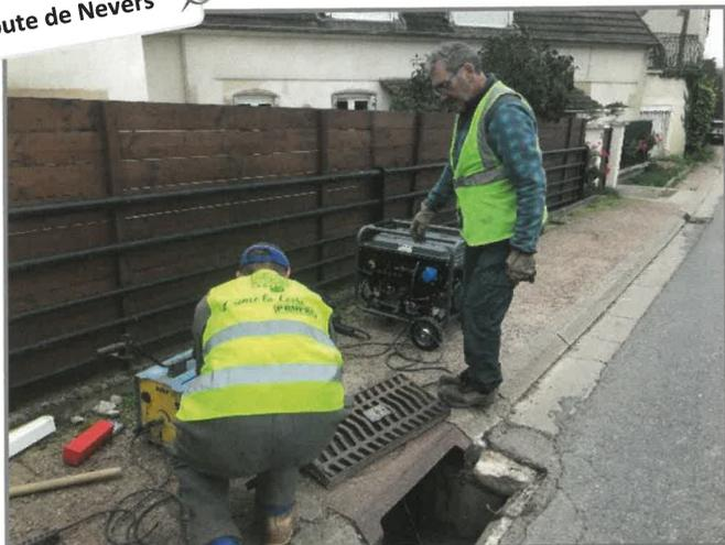
Travaux de réparation de la grille avaloir par soudage avec le groupe électrogène récemment acheté.
